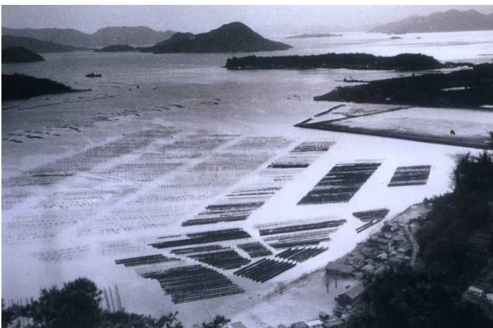
昭和36年頃(下側の広場は旧楠那小学校校庭)
